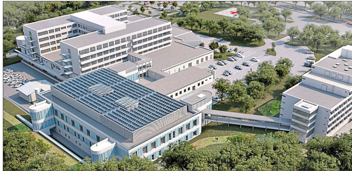
Wo jetzt noch Container stehen, wird der Neubau (im Vordergrund links) entstehen. Auf dem Plan sieht man auch den Gang, der den OP-Trakt mit dem Wohnheim (rechts) verbindet. – Foto: red
